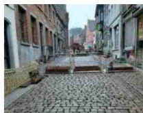
La Grand'Rue est en cours de pavage. © D.R
