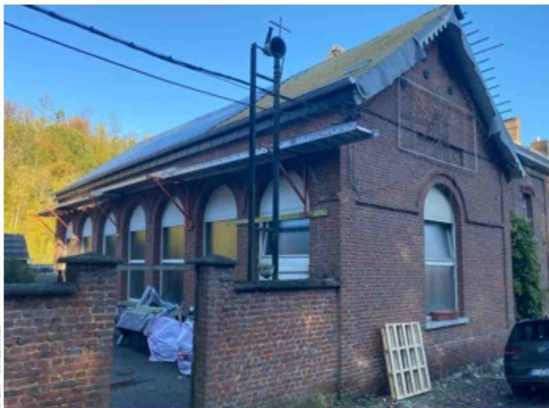
Le gros poste de la rénovation de la chapelle d'Hourpes est le remplacement de la toiture.
